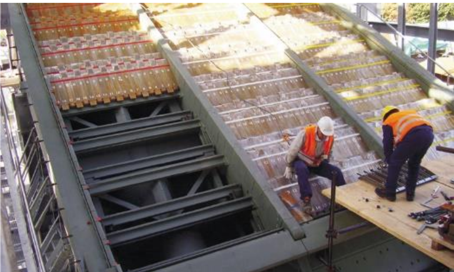
Assembly of a reciprocating grate Vario, with kind permission of Martin GmbH für Umwelt- und Energietechnik
